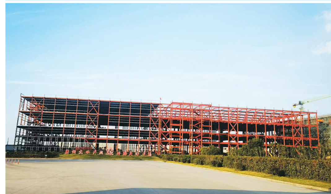
浙江大丰二期项目现场
